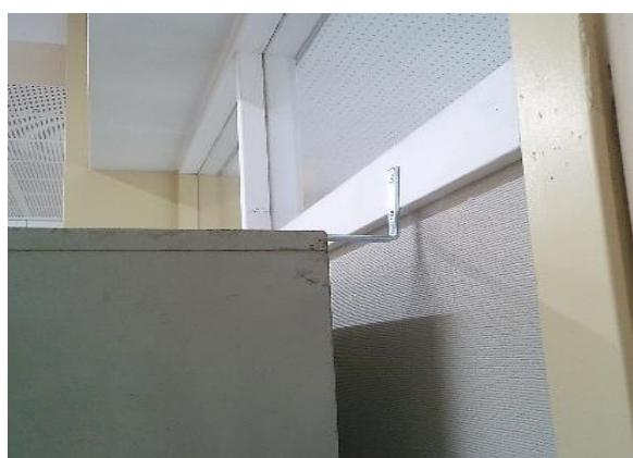
【非構造物の耐震工事・棚の固定】
