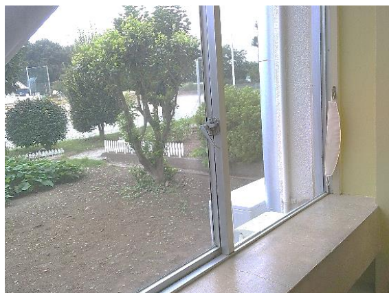
【窓ガラス飛散防止及び遮断フィルム貼り付け】
