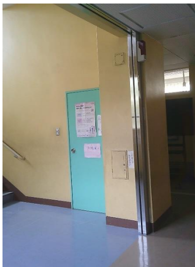
【防火シャッターの一部更新】
