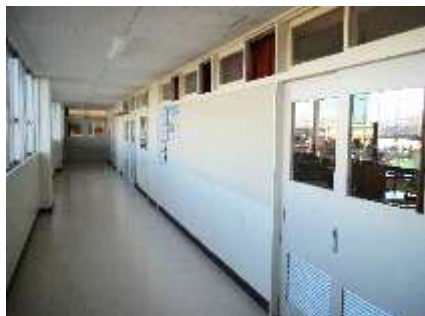
特別教室の改修
