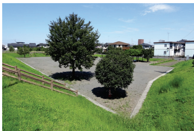
施工事例 (公園貯留池)
