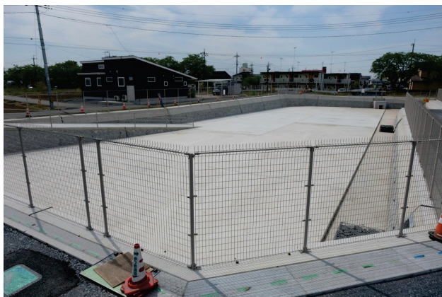
施工事例 (ブロック積調整池)
