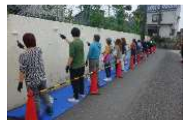
【外壁ペンキ塗り】
